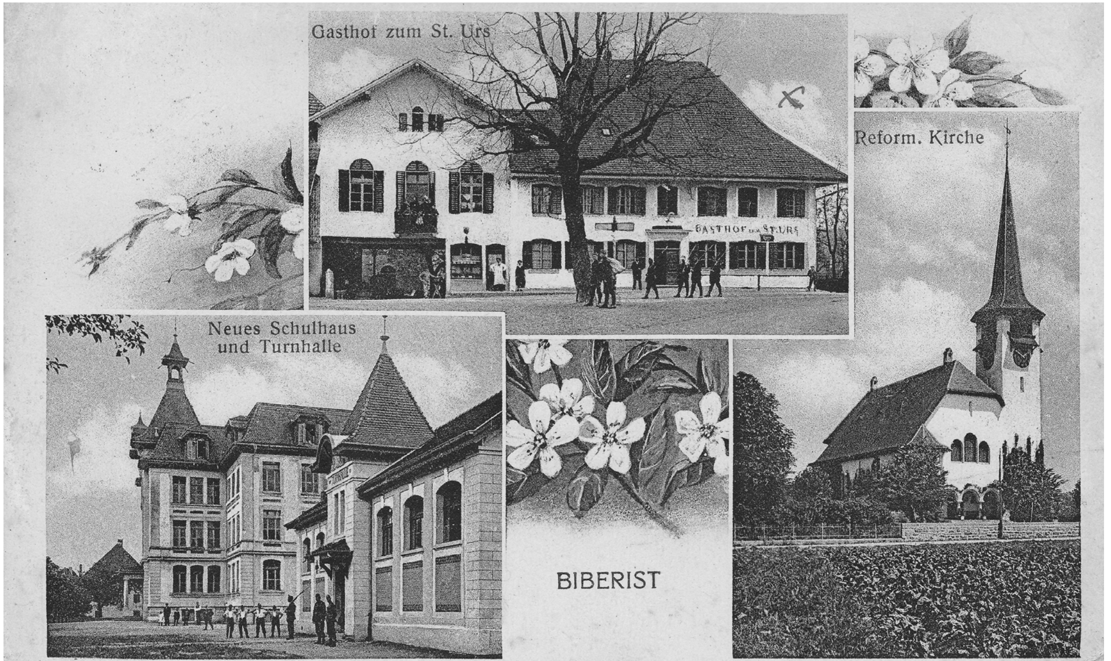
Die Ansicht einiger namhafter Gebäude in Biberist stammt aus dem Jahr 1918. Anstelle des Restaurants St.Urs steht nun ein neues, markantes Bauwerk, während das Schulhaus und die reformierte Kirche (Thomas Kirche, gebaut 1910) ihr Äusseres kaum verändert haben. Bild: Archiv Foto Grossen
