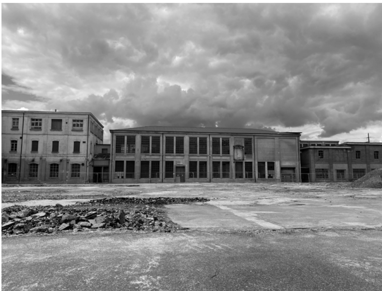
Diese nicht zum Abbruch freigegebenen Gebäude verhindern die geplante Erschliessung. Foto: Agnes Portmann-Leupi
